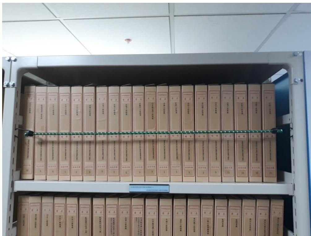
檔案架上使用彈力伸縮繩，防止地震發生時造成檔案散落之情形
