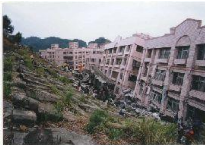
圖8 1997年溫妮颱風造成林肯大郡坡地崩塌災情 資料來源：工研院能資所-林肯大郡災變勘查報告
